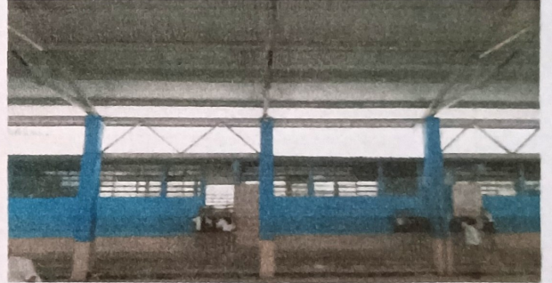
Foto 4: se colo co lamina Trokelada con pistole de impacto
