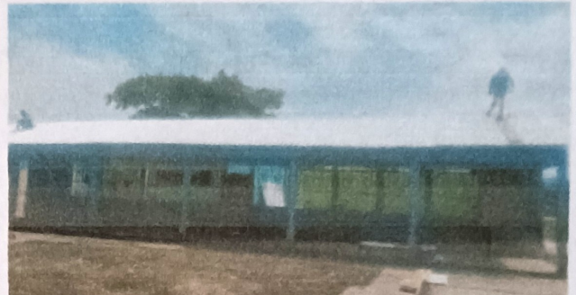
Foto 2: se instala lamina Trokelada
